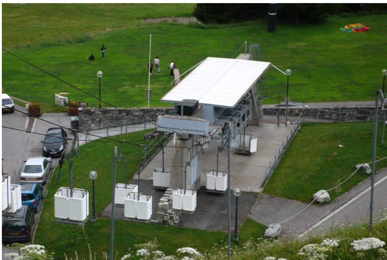
La gare inférieure de la télébenne des Grands Vans depuis le nord
