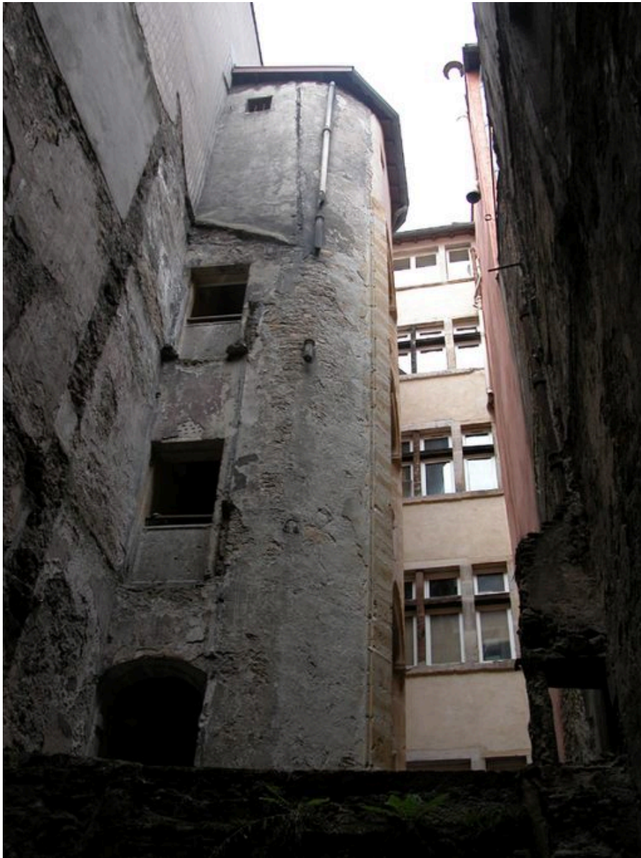
Vue générale des élévations postérieures depuis la cour du 60 rue Mercière
