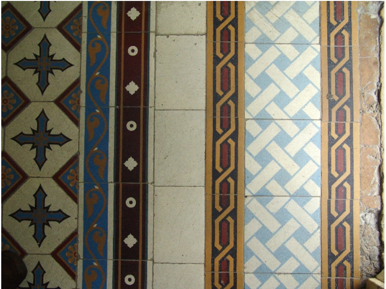
Carrelage du rez-de-chaussée, détail
