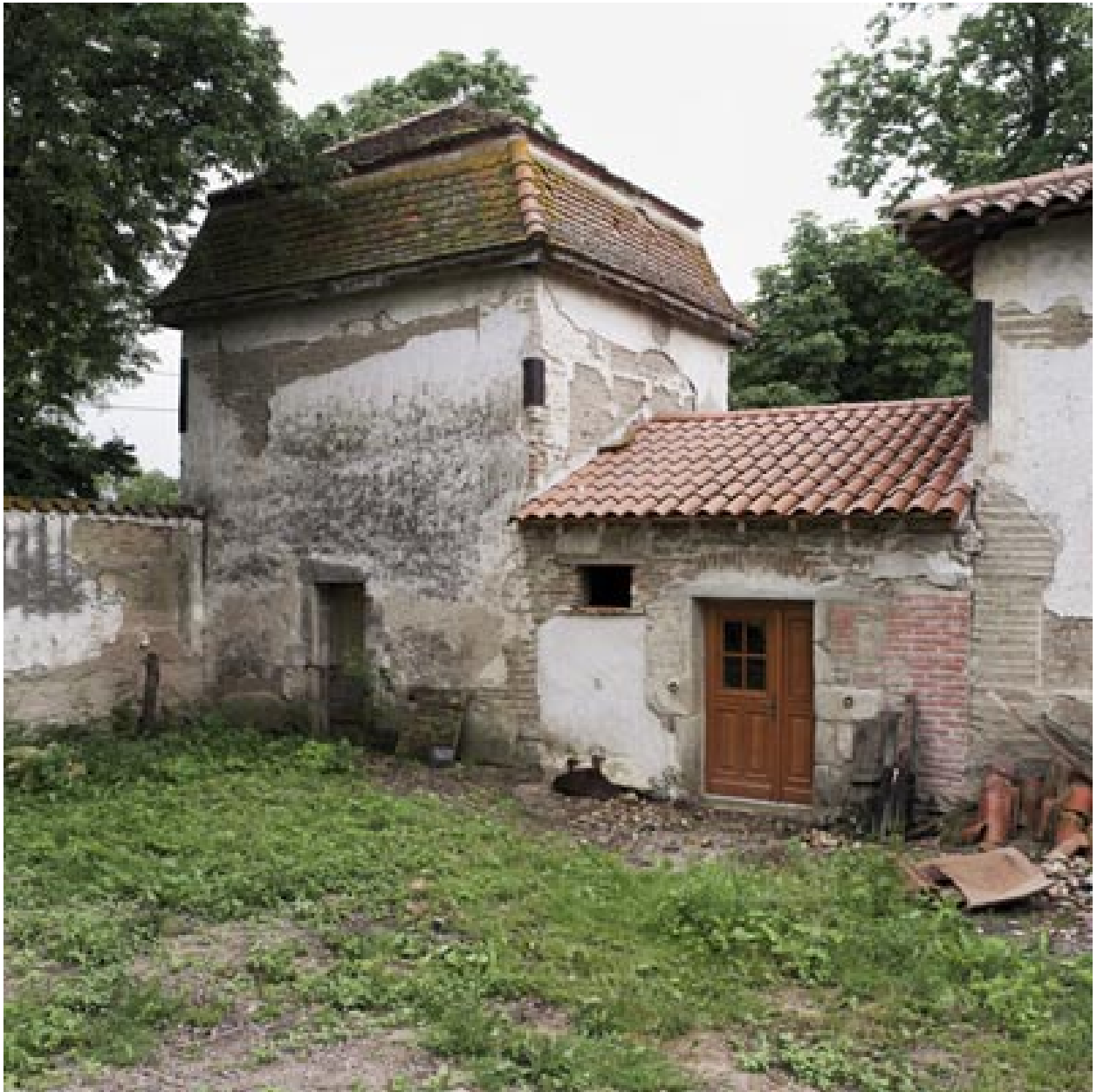
Vue d'ensemble du bâtiment sud des communs, depuis l'avant-cour.
