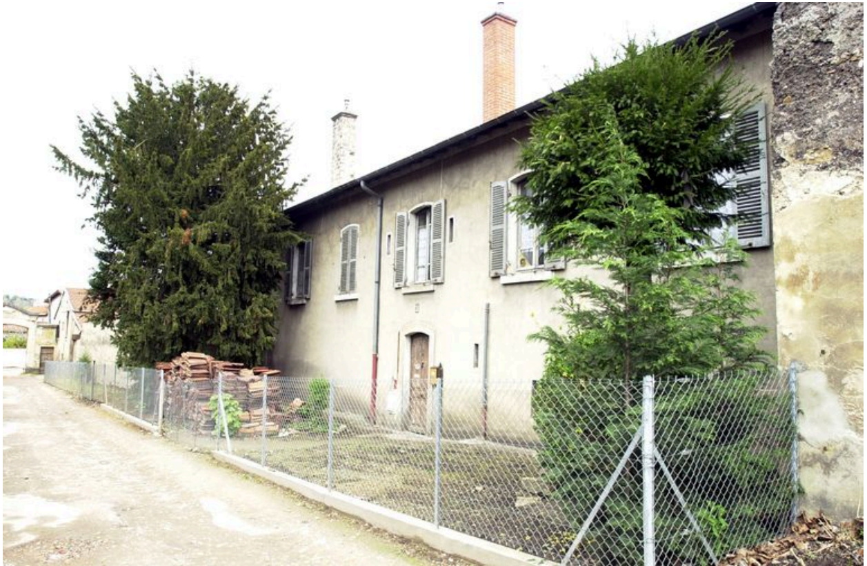
Vue d'une dépendance orientée nord-sud (BW 28)
