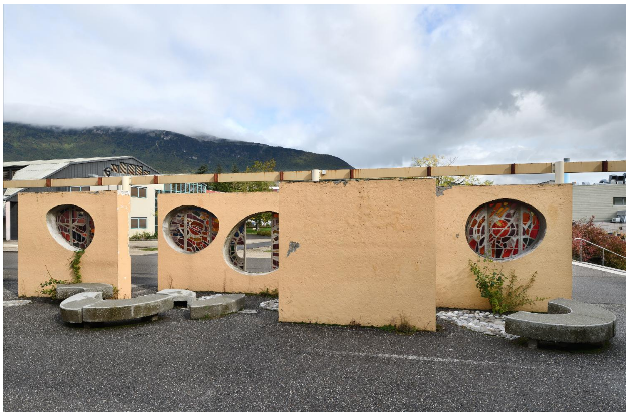
Première partie de l'installation, vue dos aux bâtiments.
