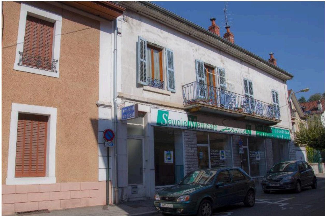
Vue de trois-quart depuis le sud-ouest
