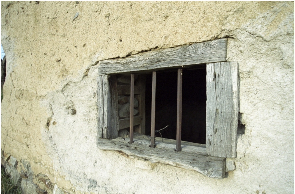
Saint-Sixte, Ciergues, loge (1987 C2 1724). Jour à barreaux métalliques.
