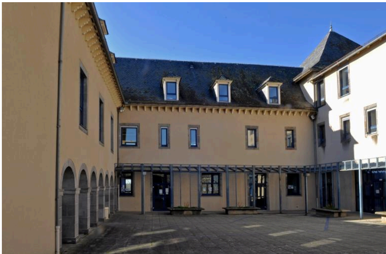
cour nord : corps de bâtiment ouest
