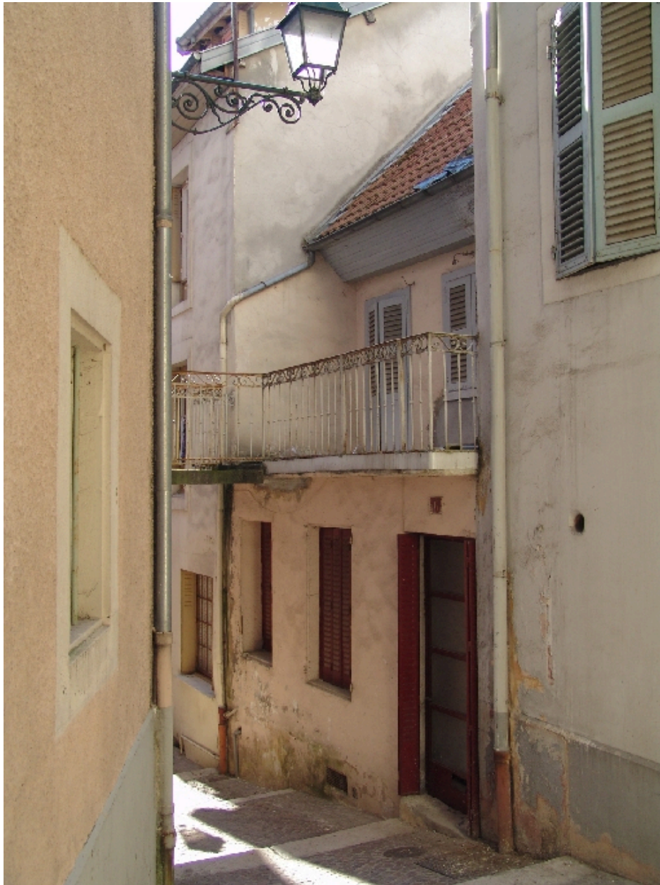
Façade sur la ruelle
