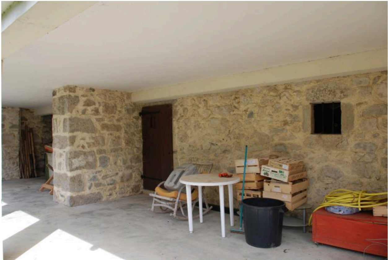
Façade avant, détail de l'étage de soubassement, partie de droite
