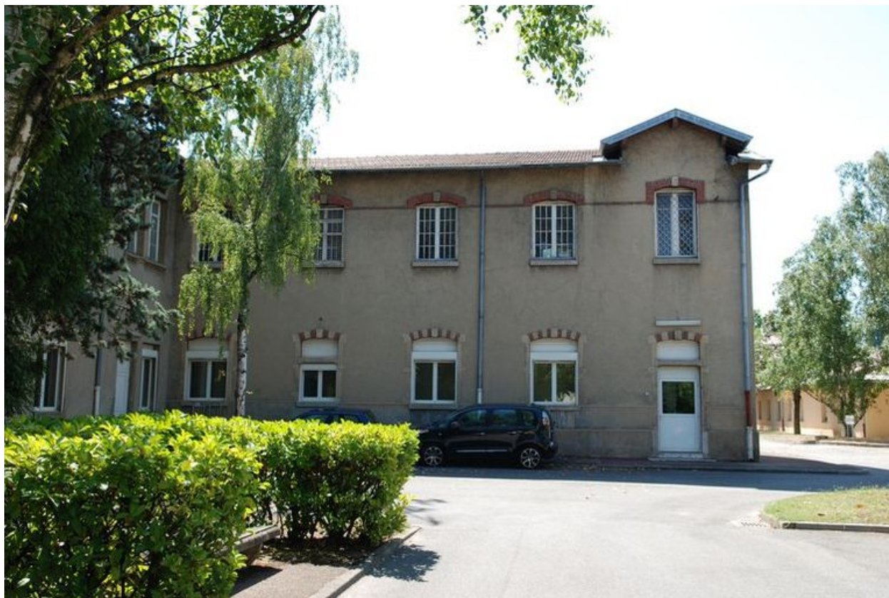
Bâtiment 456-457, façade principale (ouest), aile sud
