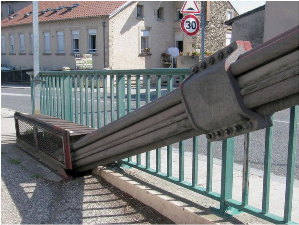
Massif d'ancrage de la rive droite
