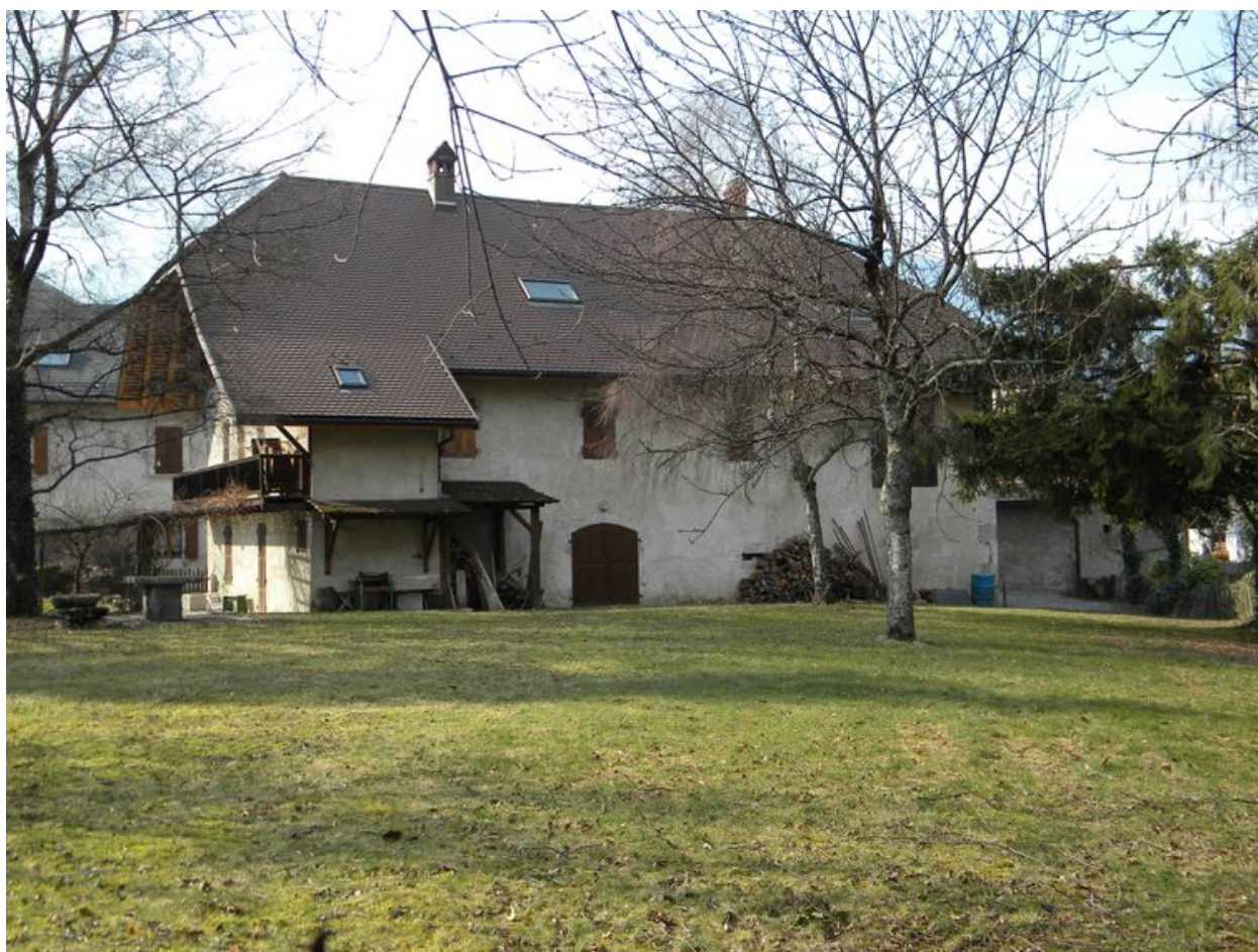
Vue de la façade arrière
