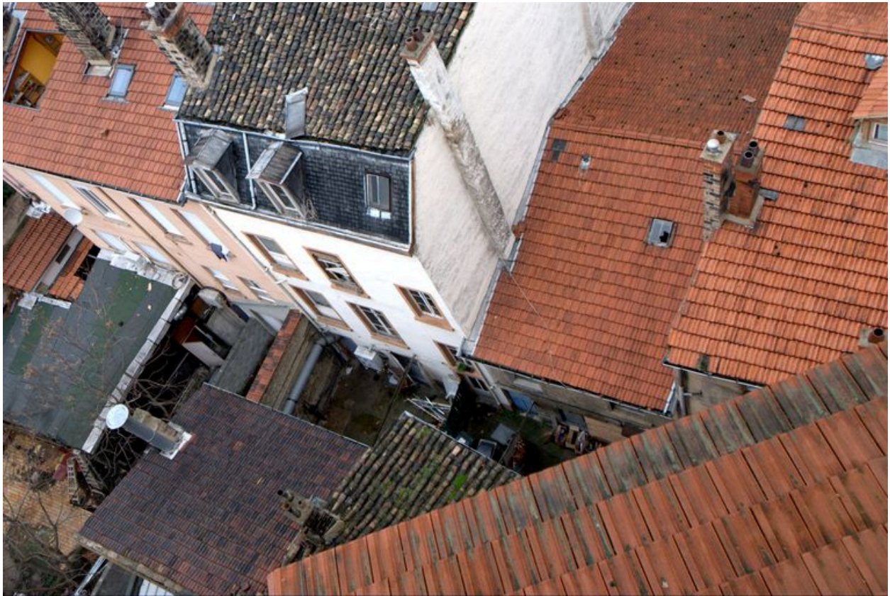
Vue du toit
