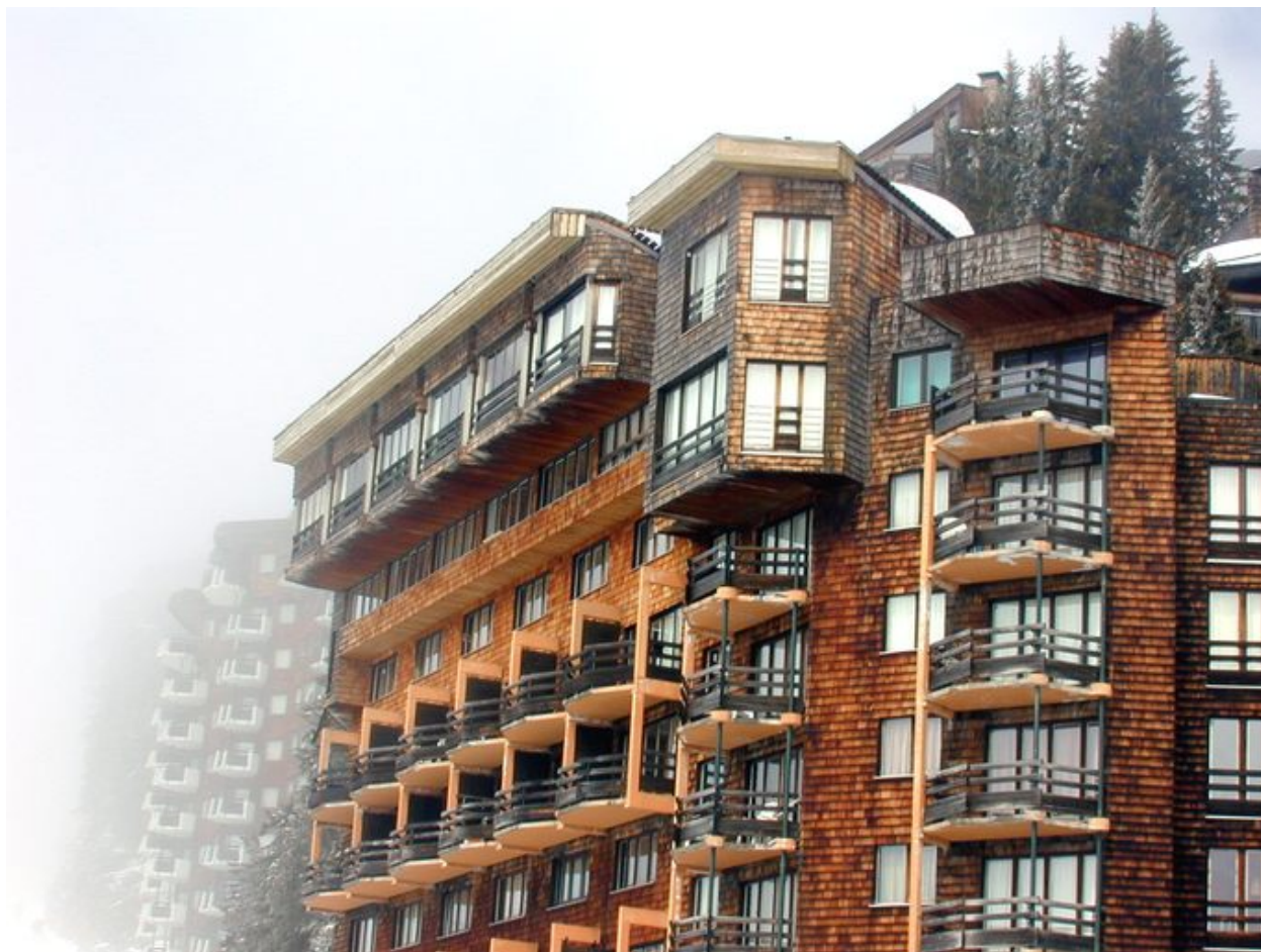
Détail des niveaux supérieurs en encorbellement, façade ouest
