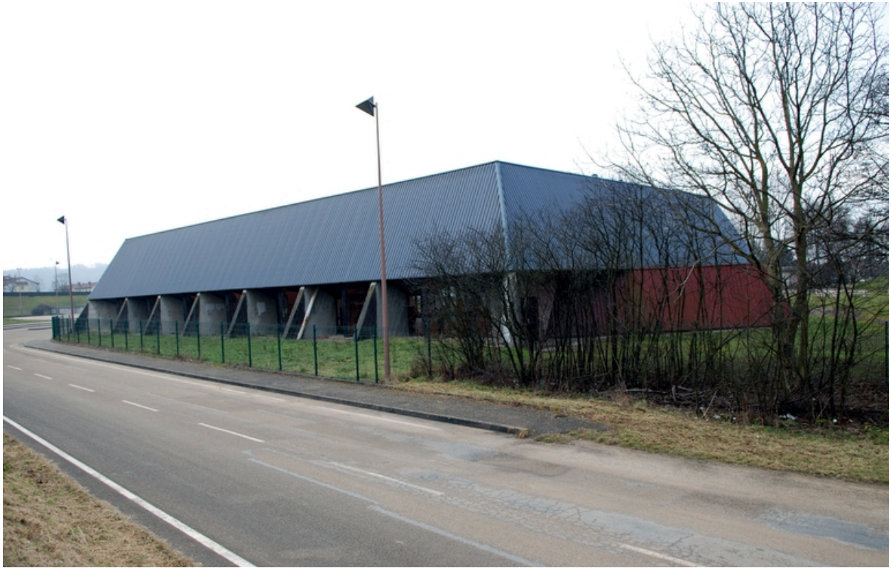
Le gymnase. Vue d'ensemble depuis le nord
