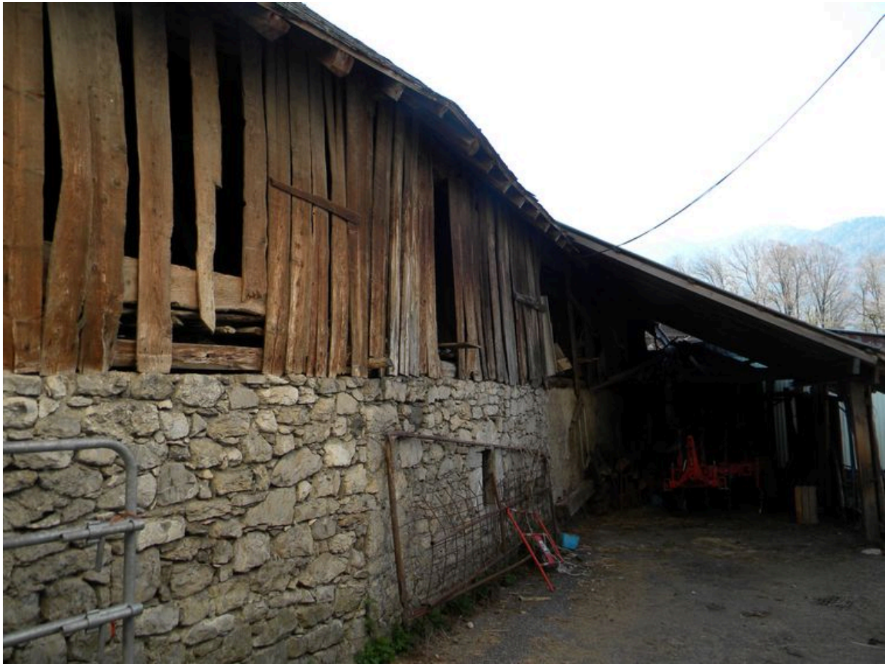
Vue de la façade arrière
