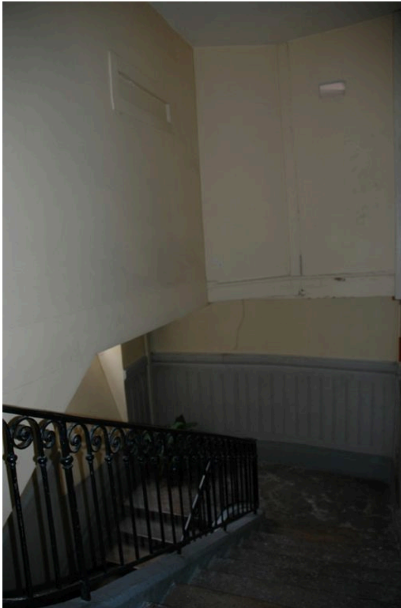
Cage d'escalier : dernier étage
