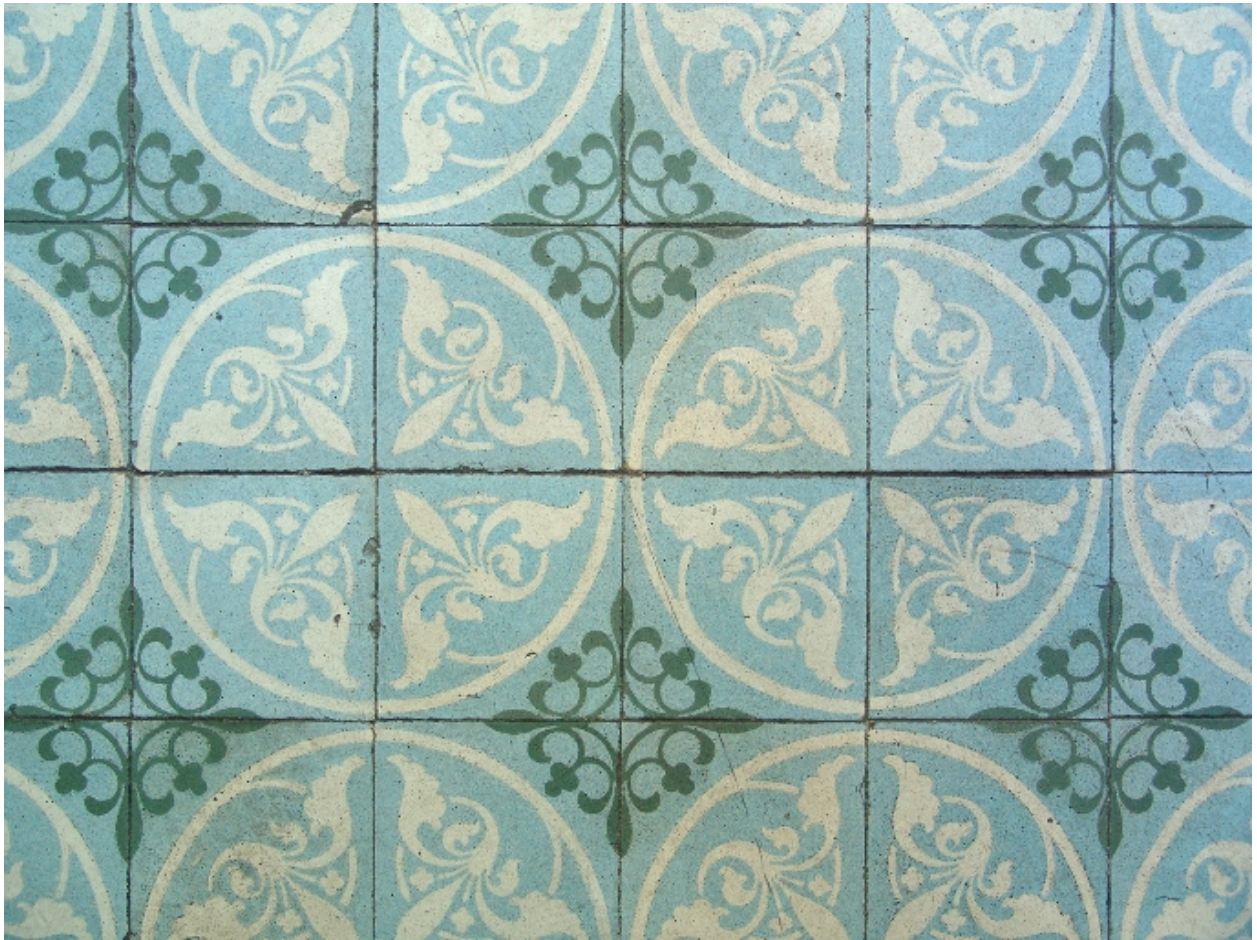
Carrelage du hall, détail
