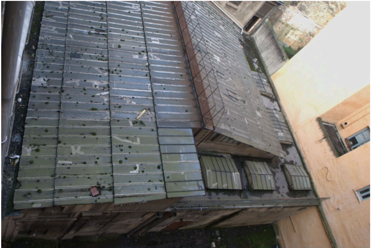
Détail de la toiture de l'atelier
