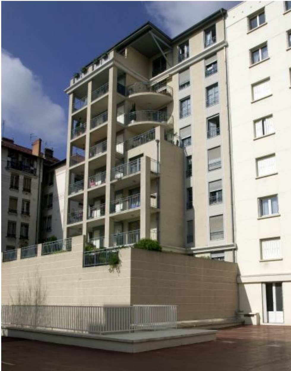
Elévation postérieure rue Quivogne depuis le nord-est
