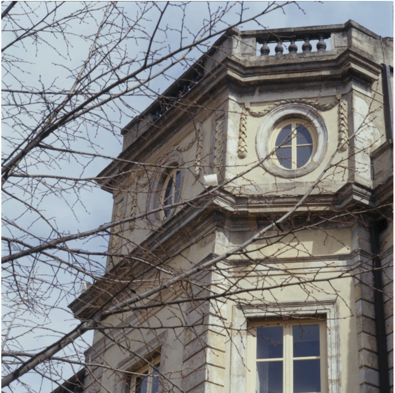
Façade sur jardin : détail de la partie supérieure de l'avant-corps central, du sud.
