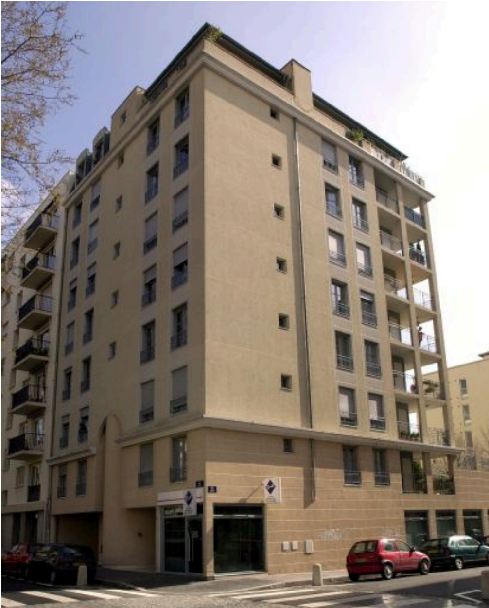
Elévation à l'angle des rues Smith et Ravat depuis le sud-ouest
