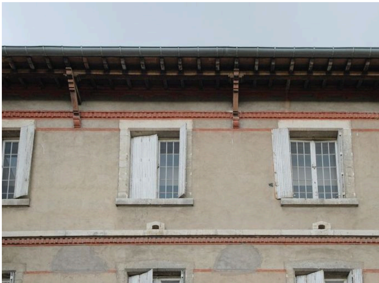
Façade postérieure : détail des bandeaux de briques, et des bandeaux, des ouvertures et des encadrement de baies en pierre de taille
