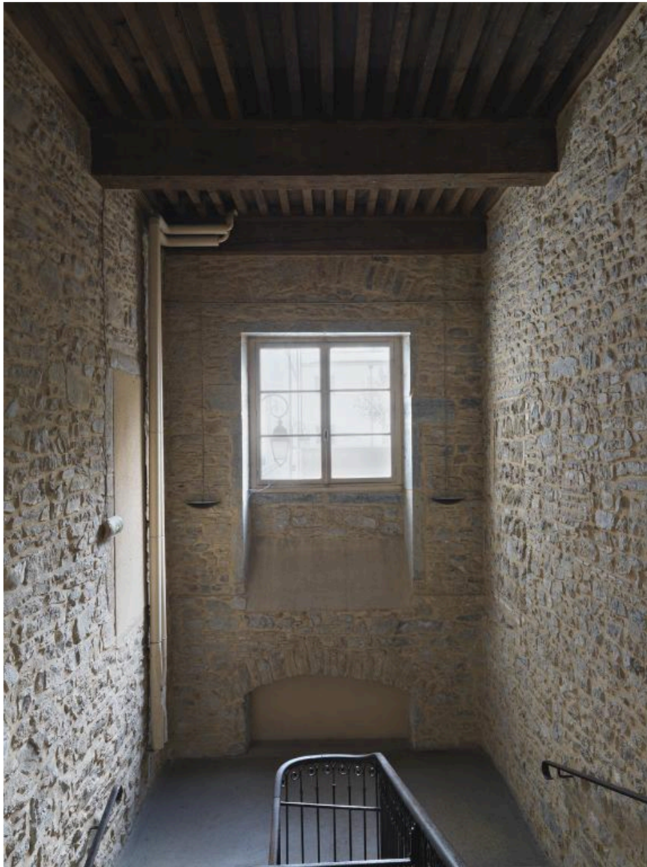
Cour d'honneur, corps de bâtiment nord : escalier B, 2ème repos
