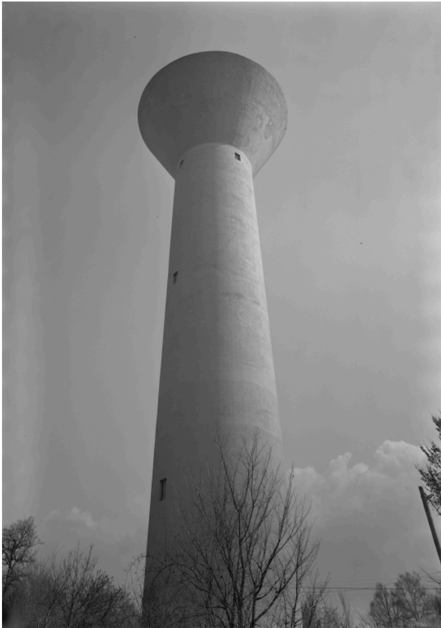
Vue du château d'eau (Cétéreau, 1986 C3 523).
