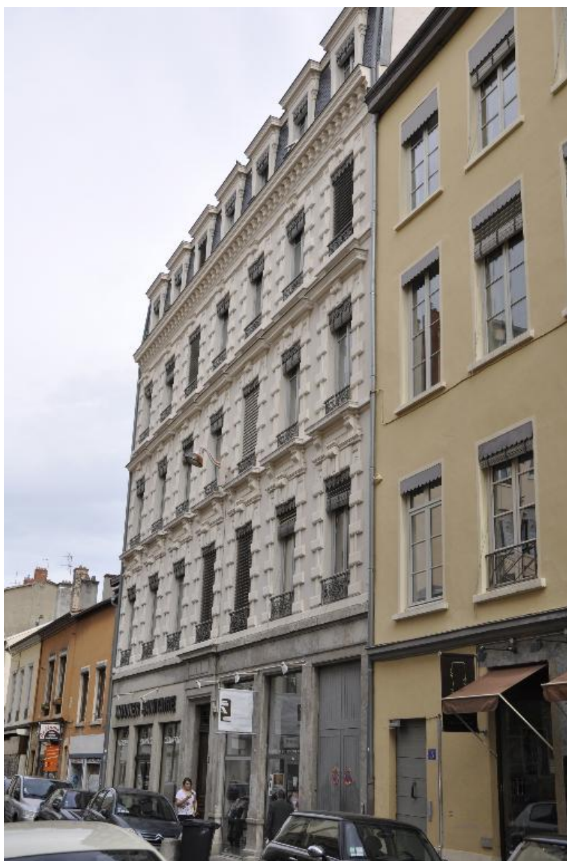
Vue d'ensemble sud est
