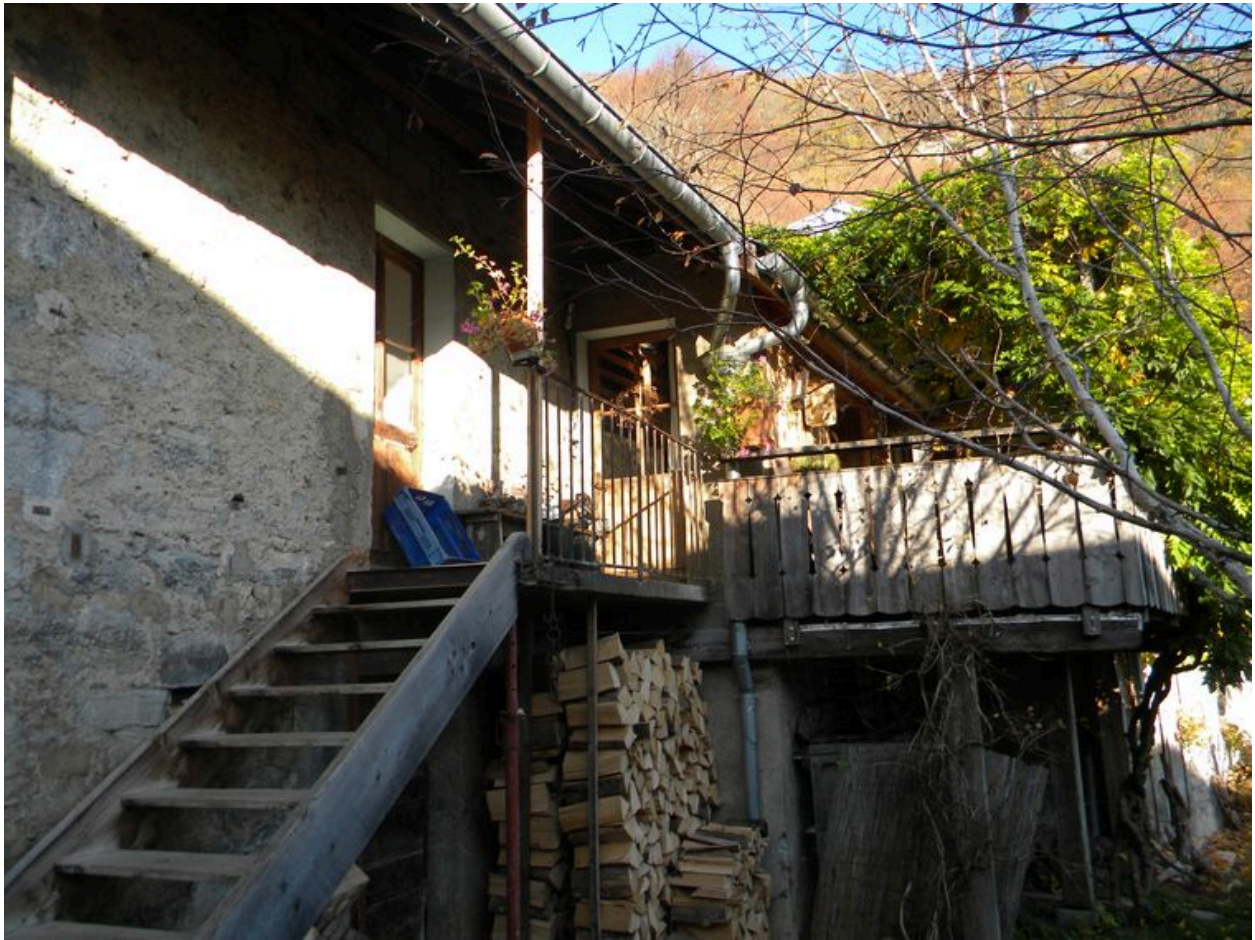
Détail de l'accès au logis en rez-de-chaussée surélevé.
