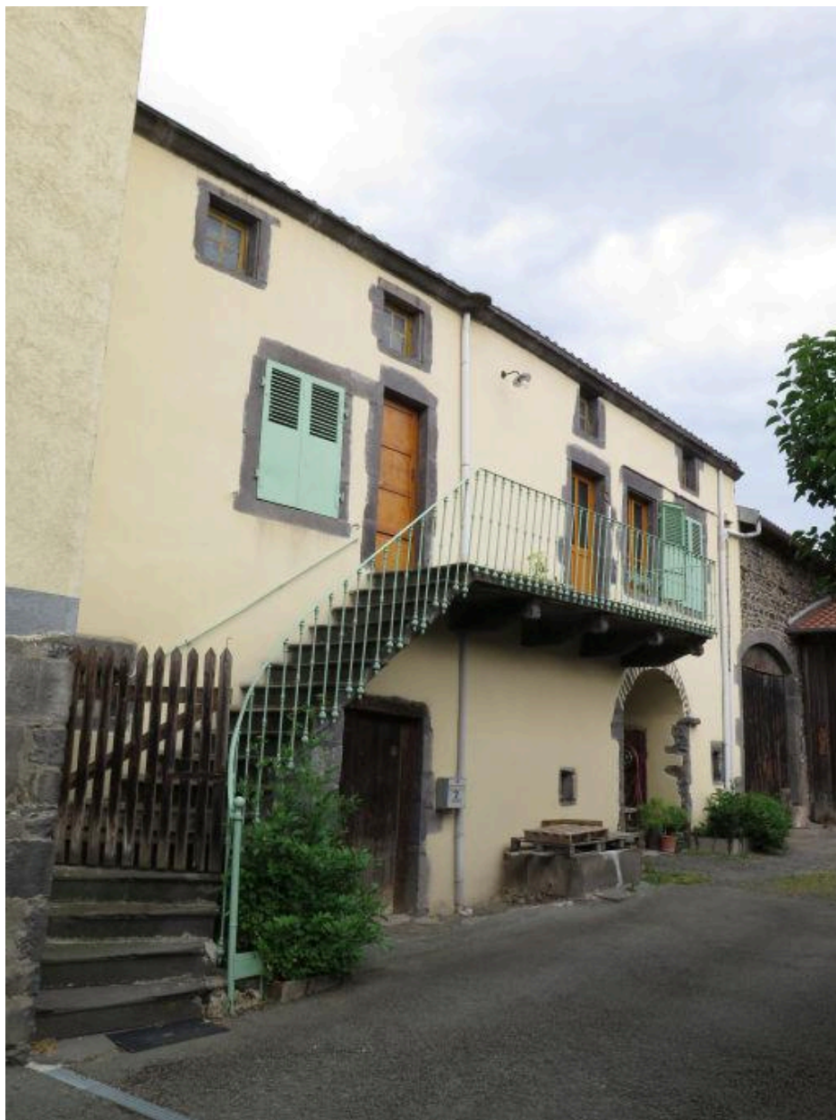
Escalier suspendu, à quartier-tournant : Châteaugay, 7 imp. des Basses-cours
