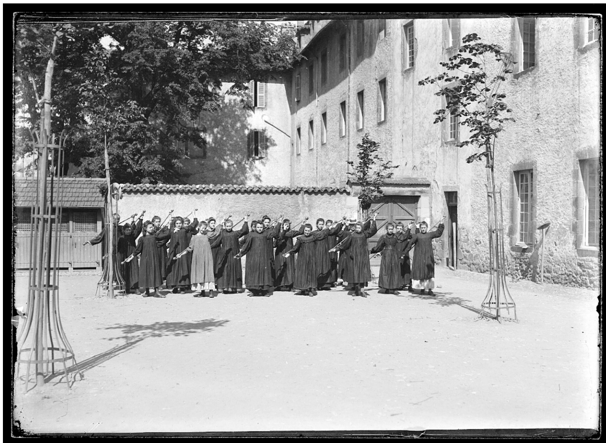
Cour du collège, côté jardin ; à droite, élévation sur cour du corps de bâtiment principal. Un mur de clôture sépare la cour de récréation de la partie donnant sur le jardin.
