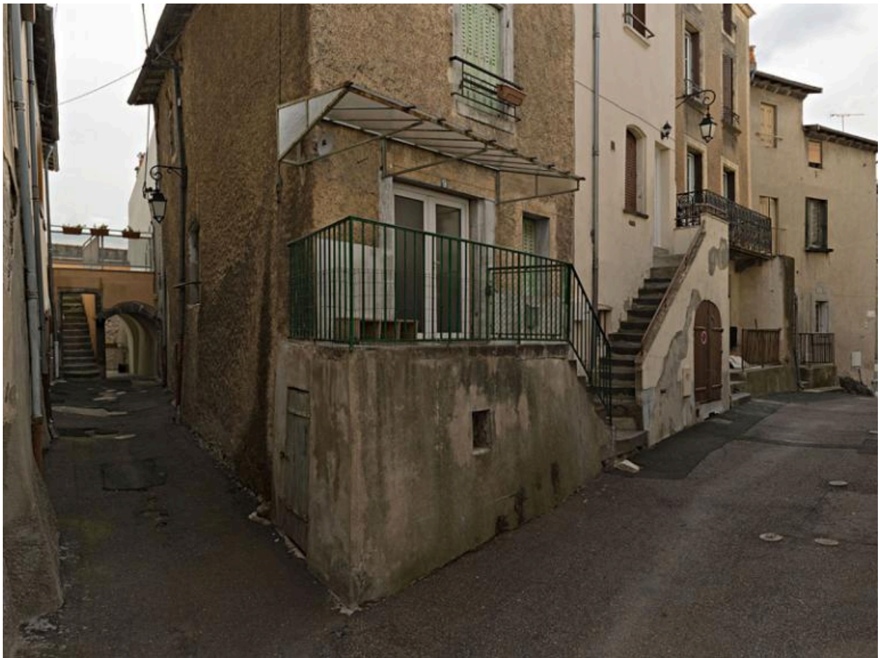
Beaumont (Puy-de-Dôme). Rue et impasse de la Liberté : escaliers en saillie et passage surélevé entre immeubles (jouant probablement le rôle d'arc-étrésillon).
