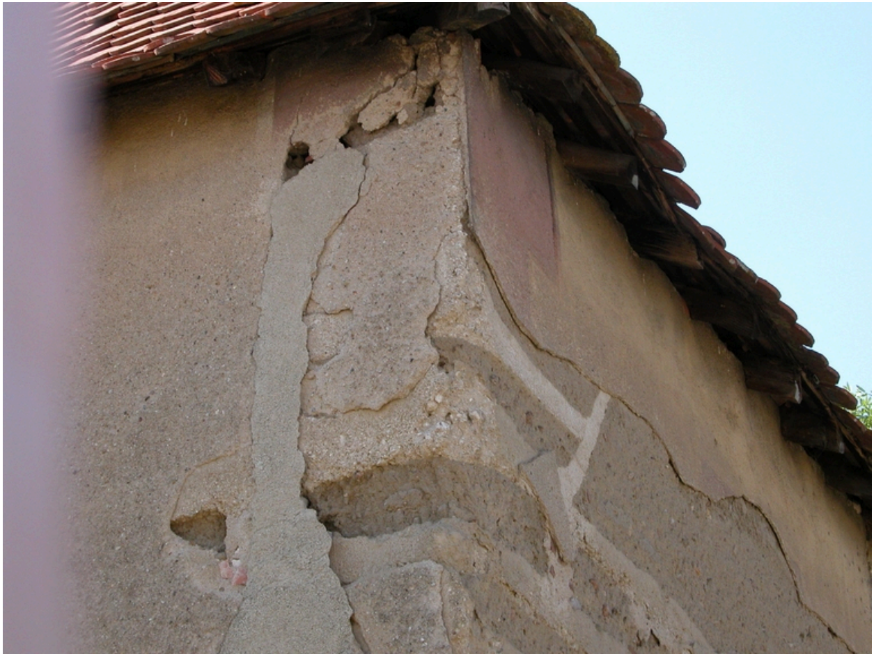
Détail de l'enduit peint.
