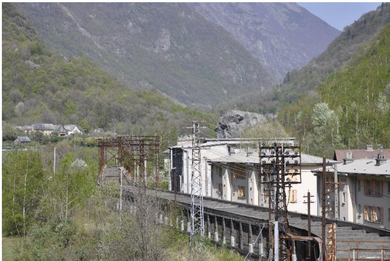
Vue du canal
