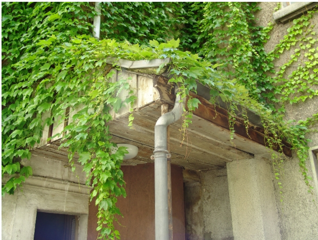
Détail de l'entrée
