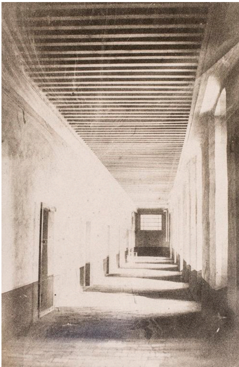
Vue du couloir du premier étage du bâtiment F, vers 1873 (Bibl. mun. Roanne. Fonds Stéphane Geoffray 1F42/197; N°258)
