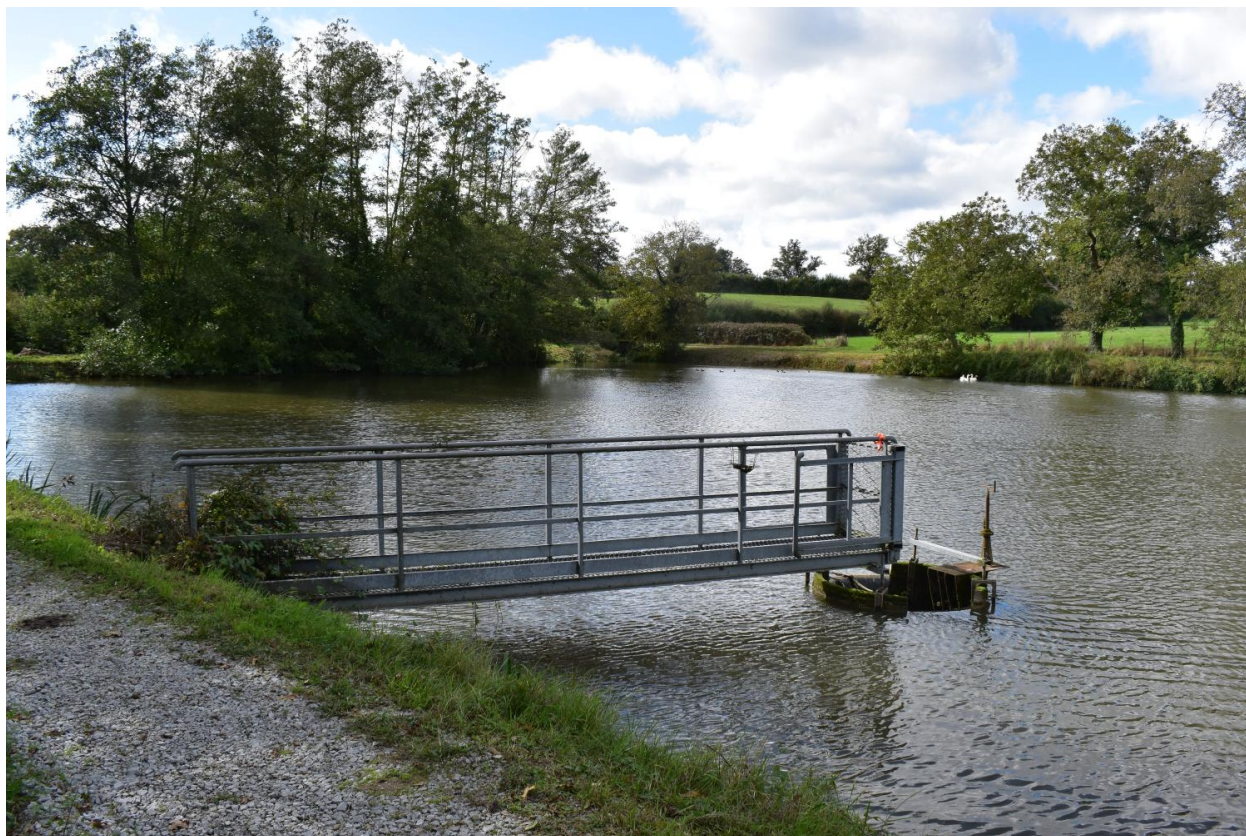
Etang : vue de la passerelle et du moine de vidange.
