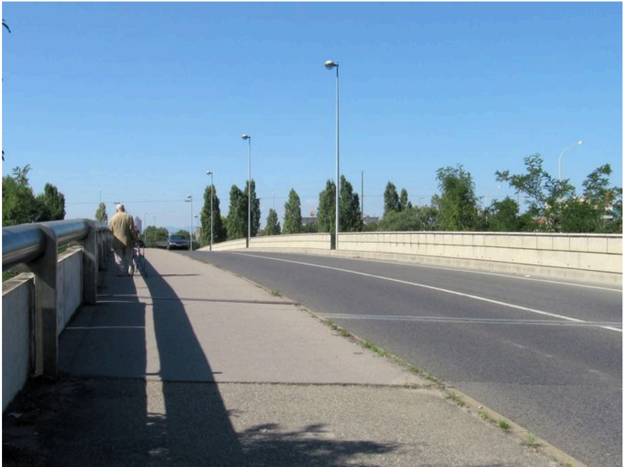
Chaussée (depuis la rive droite)
