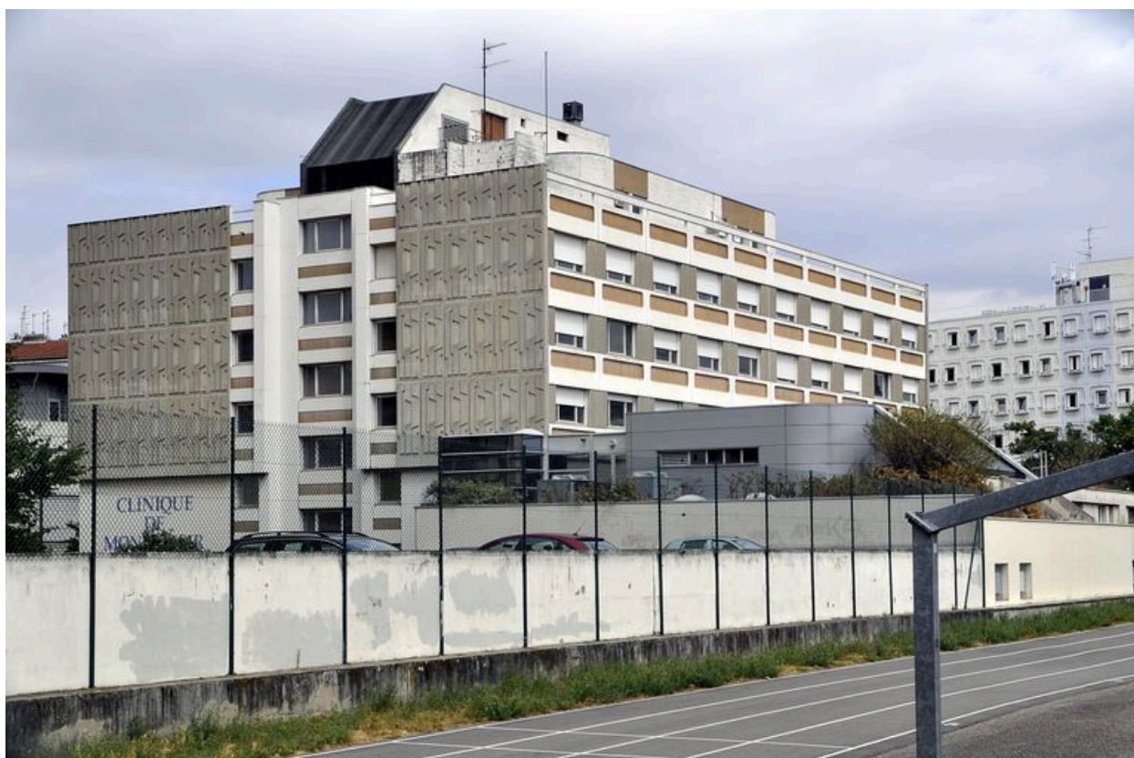
Façade postérieure sud et façade latérale ouest
