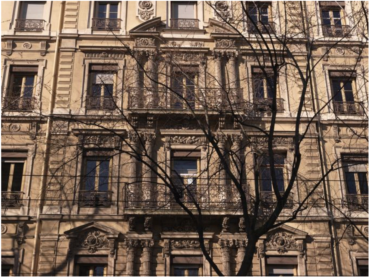
Détail de la travée centrale.
