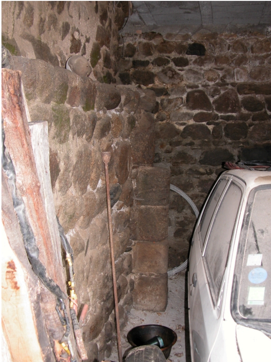
Vue des murs de la remise, adossée à l'ancienne cuisine, au niveau de l'étage de soubassement.
