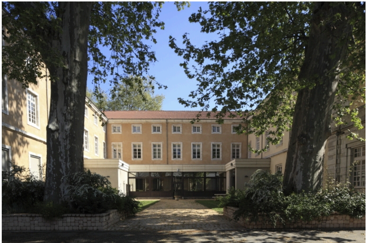
Bâtiment C. Façade occidentale, depuis le parc.
