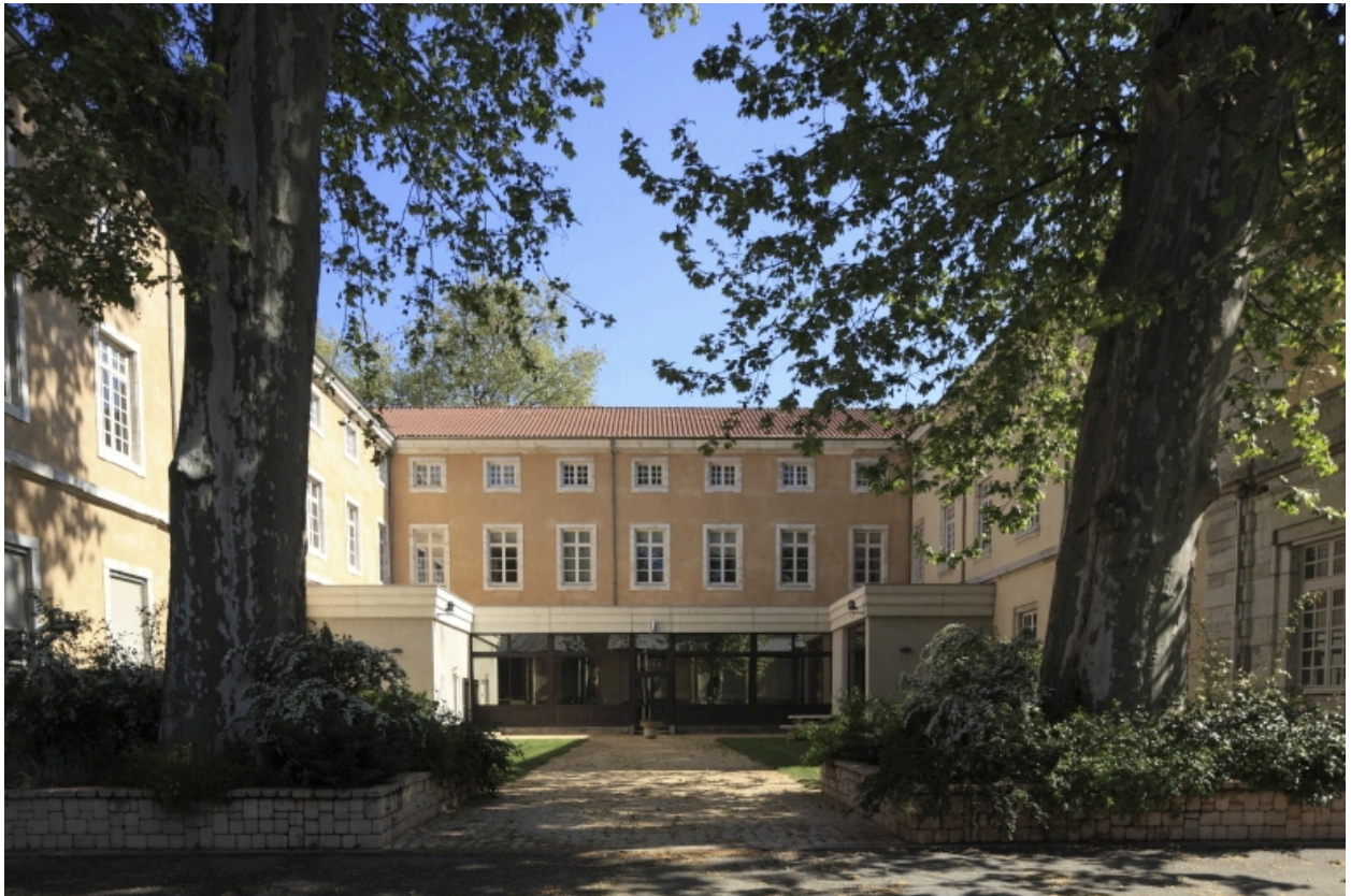
Bâtiment C. Façade occidentale, depuis le parc.
