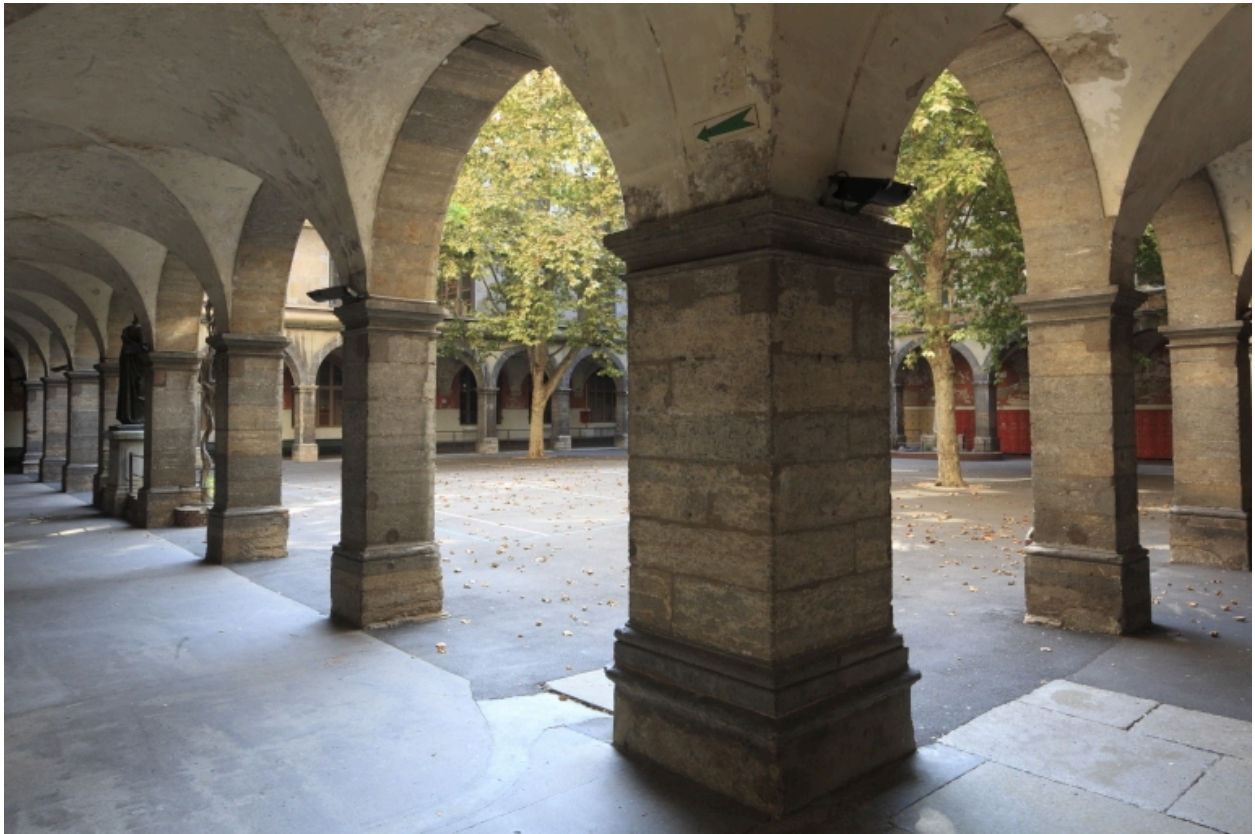
Cour du lycée. Angle nord-ouest.
