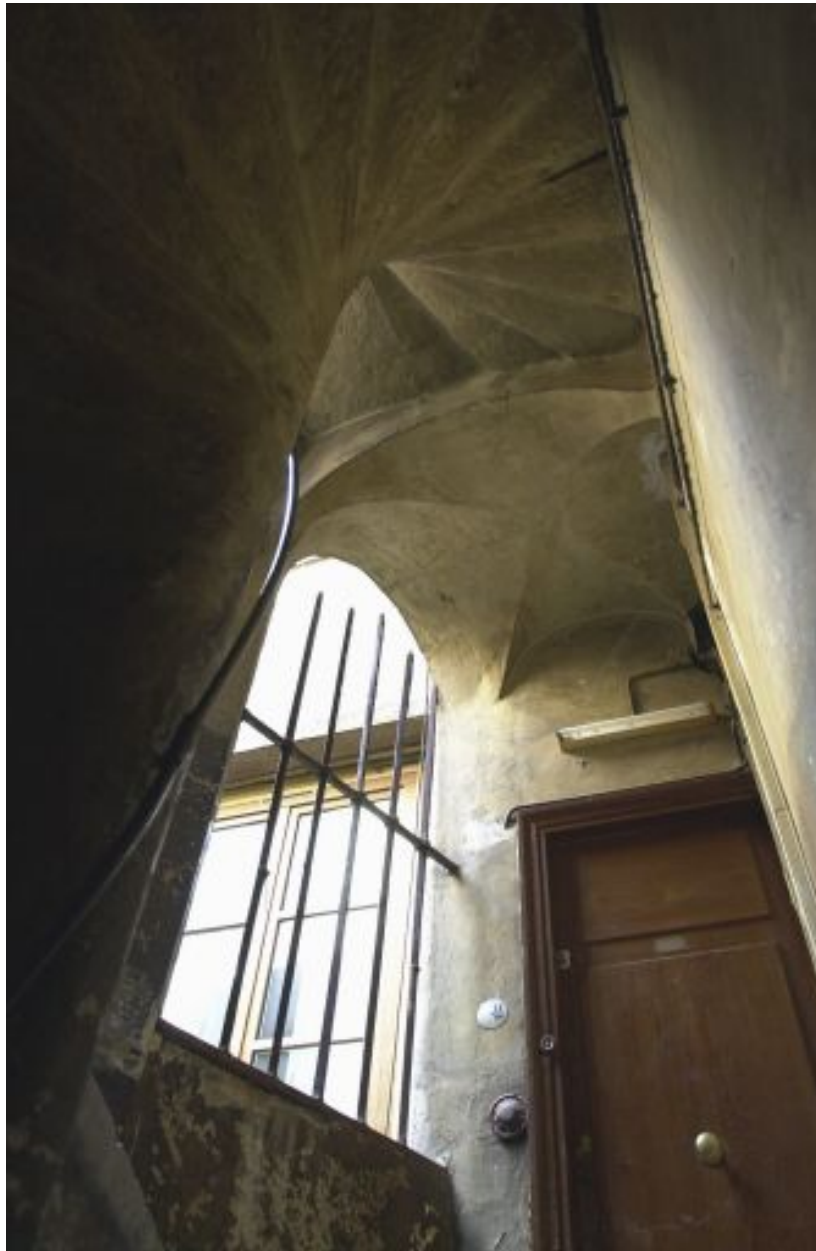
Escalier et voûte d'arêtes d'un palier
