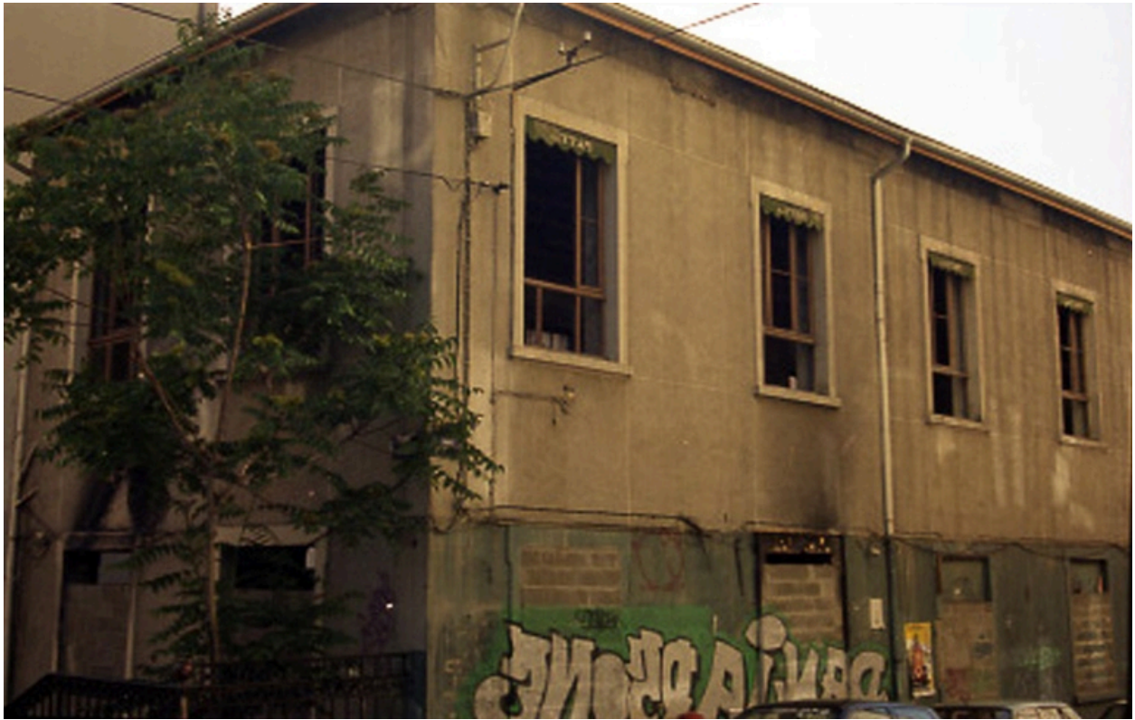
Façade angle nord-est
