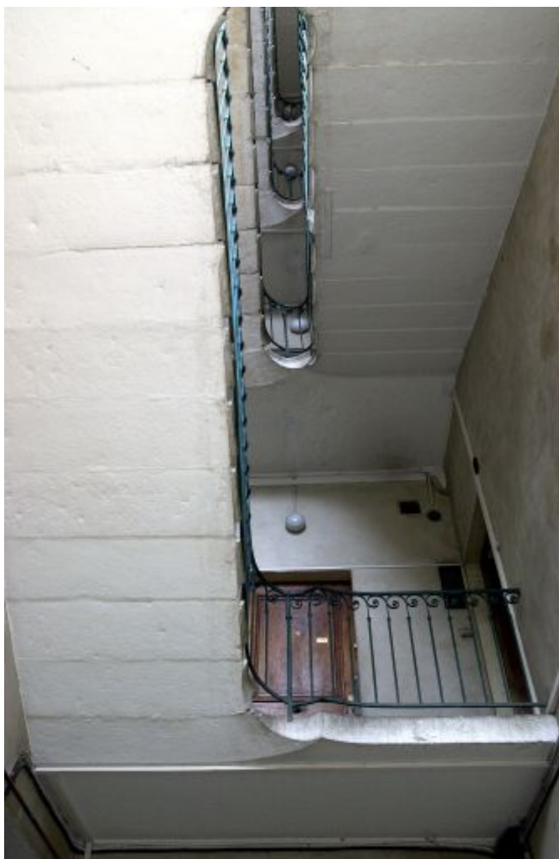
Vue de la cage d'escalier
