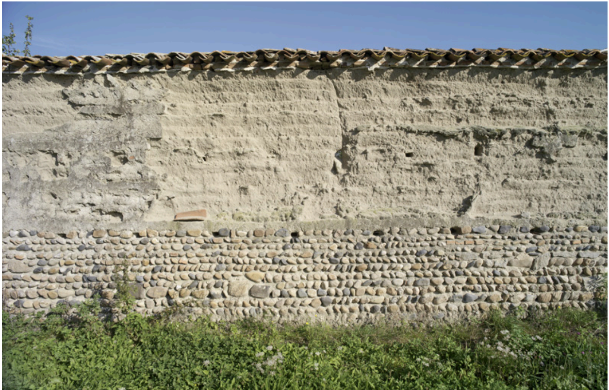
Mur en pisé sur soubassement de galets (Chalain-le-Comtal, les Rayons, ferme, IA42003515).
