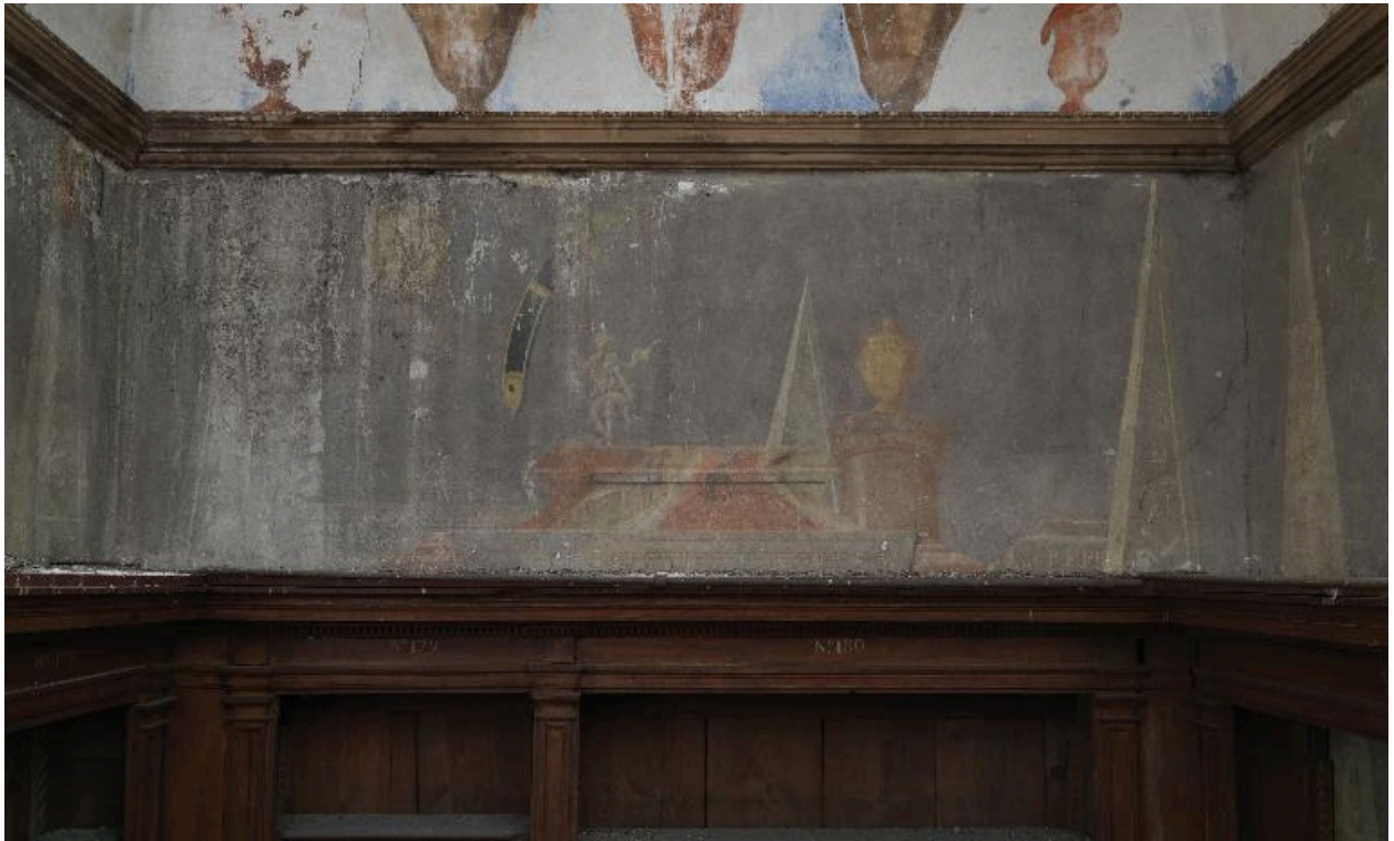
Mur ouest : vue d'ensemble
