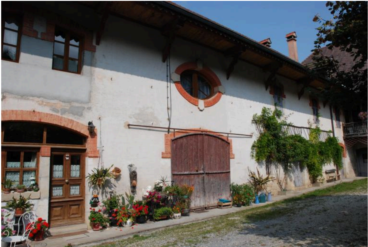
Vue d'ensemble de la partie sud de la façade est du corps de bâtiment en retour sur cour.
