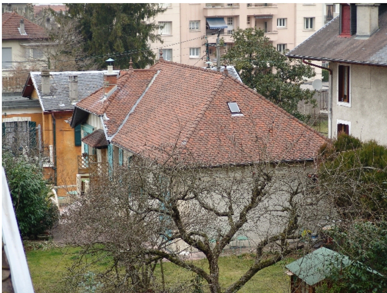
Vue d'ensemble prise de l'arrière
